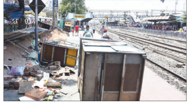
■ দমদম রেল স্টেশন। বুলডোজার চলার পর।
